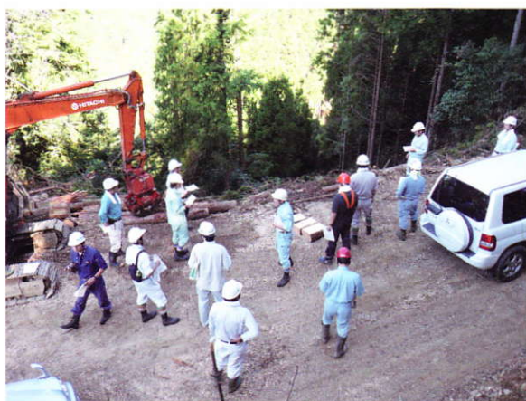
集約化施業研修 森林組合等に対して作業システムの研修
