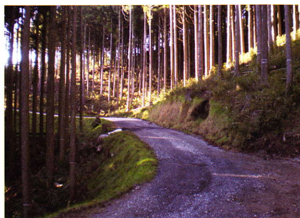
〈開設された作業道の状況 L=1,400m W=3.0m〉 (嘉麻市桑野)
