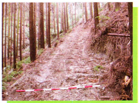
★作業道の現地調査(構造・開設方法)
