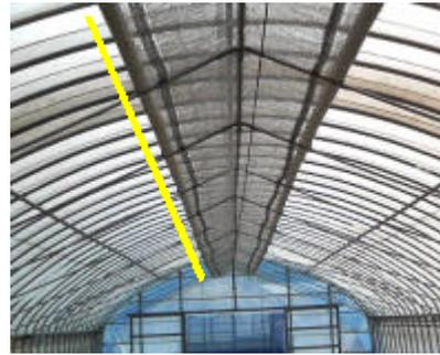
屋根型骨材による巻き上げ
