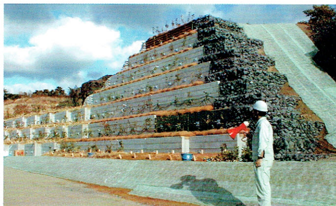
写真3 緑化ブロックの試験施工
